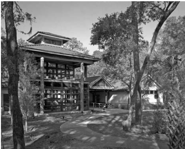
Figura 8, 9 - Edisto Beach Interpretive Center, Edisto Island, Carolina do Sul, EUA. Fonte: < http://www.designshare.com/projects/view.asp?p=images&pid=436&img=3396 >. Acesso em: 25 abr. 2006.
