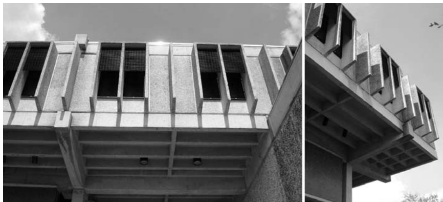
Figura 172 e 173 - Edifício que abriga as faculdades de Arquitetura, Biologia, Matemática e outras atividades. Fotos de set. 2005
