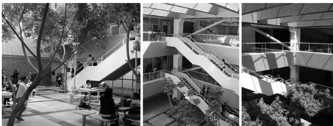
Figura 254, 255, 256 - Pátio interno do edifício de Licenciaturas no campus Coyoacán da UNITEC. Fotos de fev. 2006
