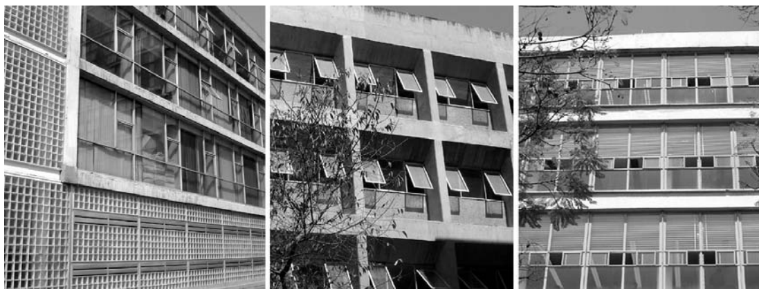
Figura 205, 206, 207 - Fachadas de diferentes edifícios do Campus Universitário da UNAM. Fotos de fev. 2006
