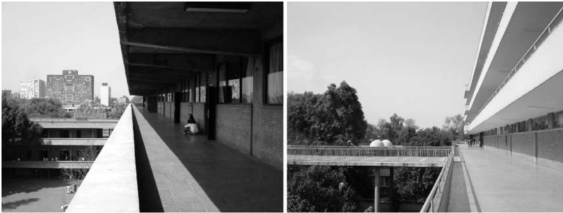
Figura 219, 220 - Balcão/ corredor externo da Faculdade de Arquitetura (esquerda) e da Faculdade de Engenharia (direita) da UNAM. Fotos de fev. 2006
