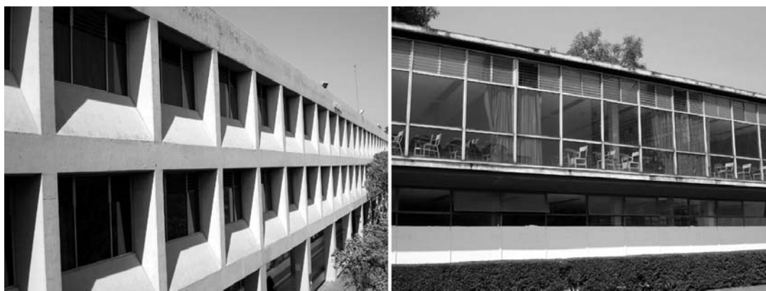
Figura 214, 215 - Fachadas de diferentes edifícios do Campus Universitário da UNAM. Fotos de fev. 2006
