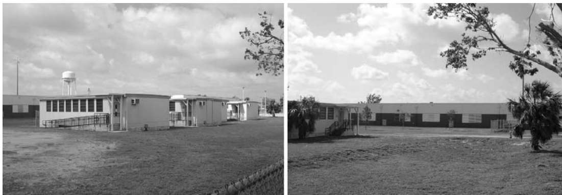
Figura 201, 202 - Escola em Fort Lauderdale: edifício principal ao fundo, salas de aula temporárias a frente. Fotos de mar. 2006
