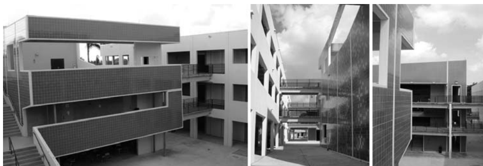
Figura 193, 194, 195 - Escola de Arquitetura da FIU. Fotos de set. 2005
