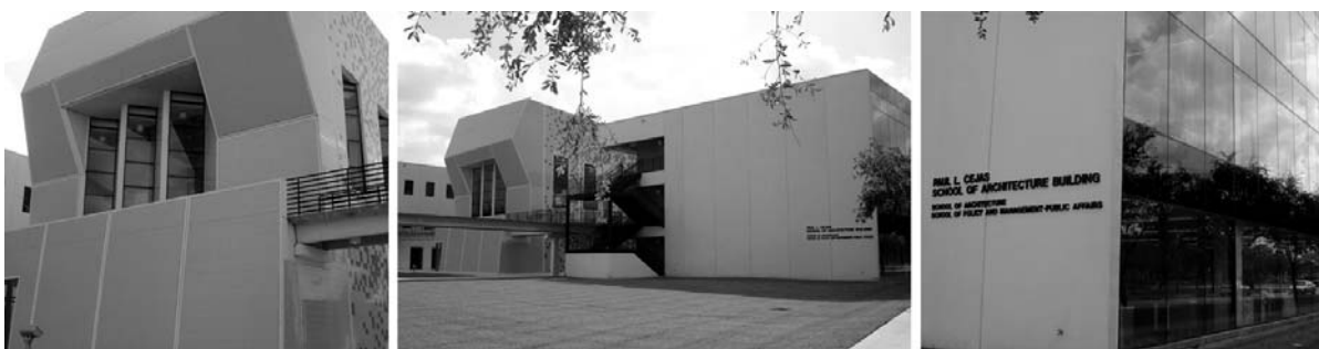
Figura 190, 191, 192 - Escola de Arquitetura da FIU. Fotos de set. 2005
