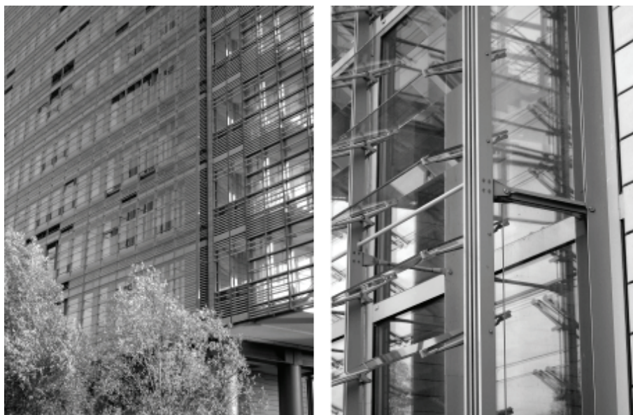
Figura 2: Edifício Debis, em Berlim, Alemanha (1997). Detalhe de uma variante de fachada dupla ventilada em edifícios altos, com a camada exterior passível de abertura (à direita) Crédito: Autora
