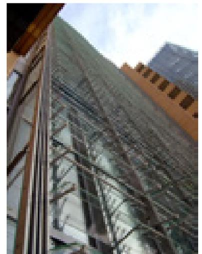
Figura 48. Edifício Debis, em Berlin: detalhe da fachada dupla ventilada
