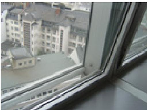
Figuras 41 e 42. Edifício Commerzbank: detalhe da fachada de um escritório periférico, com elementos de proteção solar e esquadrias móveis para ventilação natural
