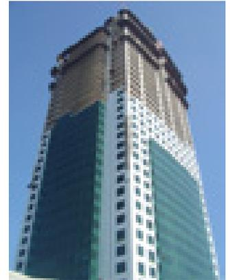
Figura 102. Edifício Eldorado Business Tower: vista exterior da fachada NE, observando-se a estrutura sob o vidro verde.
