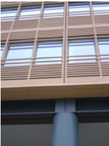
Figura 46. Edifício Debis: detalhe do brise cerâmico na fachada externa
