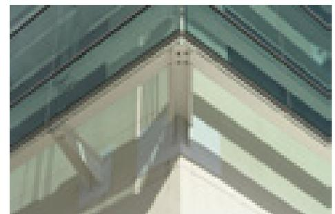
Figura 111. Edifício Cidade Nova: vista da fachada dupla ventilada, com detalhe da abertura inferior para ventilação (Créditos: Celso Brando e Alex Ferro)
