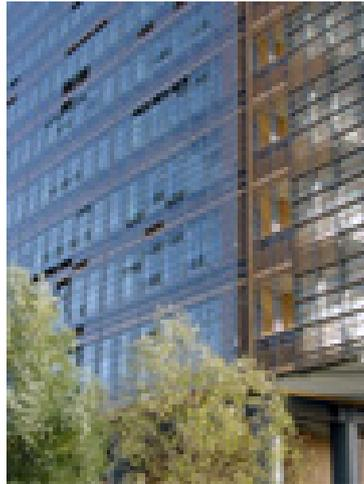
Figura 44. Edifício Debis, em Berlin: vista da fachada dupla ventilada, à esquerda, e da fachada com brises cerâmicos, à direita
