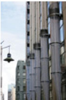
Figura 87. Edifício CH2: "shower towers" presentes na fachada Sul (Fonte: City of Melbourne, 2008)
