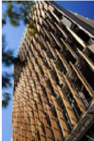
Figura 82. Edifício CH2: brises de madeira pivotantes na fachada Oeste (Fonte: City of Melbourne, 2008)
