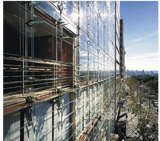
Figura 80. Edifício Aurora Place: detalhe da fachada dupla ventilada com a segunda pele aberta (Fonte: Marcondes, 2004)
