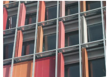
Figura 53. Edifício GSW: brises móveis na cavidade da fachada dupla ventilada (orientada a oeste). (Fonte: LNBL, 2002)
