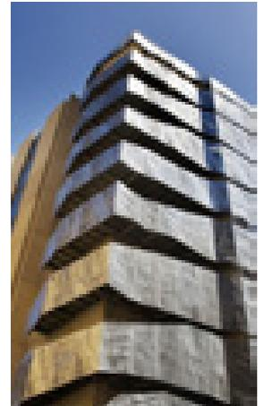
Figura 84. Edifício CH2: painéis metálicos perfurados na fachada Leste (Fonte: City of Melbourne, 2008)
