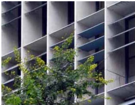
Figura 05 – Detalhe do brise – Soleil do Ministério da Educação e Saúde Pública do Rio de Janeiro
